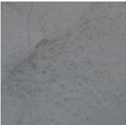
Schwundrisse und kleine Poren durch die Estrichkonstruktion
